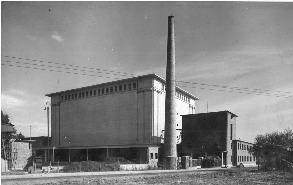
Kaposvári Hűtőház, 195?, Építész? (MEZŐTERV-IPARTERV?)
